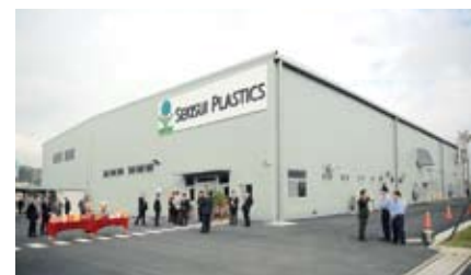
新設多目的工場
