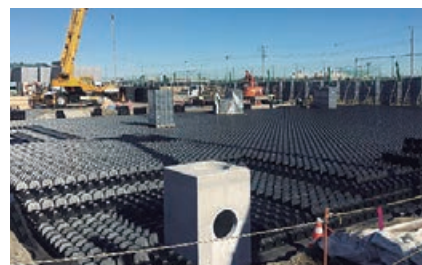
アクアロード埋設工事現場
