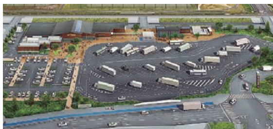
道の駅「いちかわ」全景
