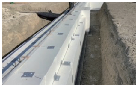
エスレンブロックRNW施工風景
