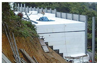
「エスレンプロック」 EPS土木工法用 軽量盛土材
