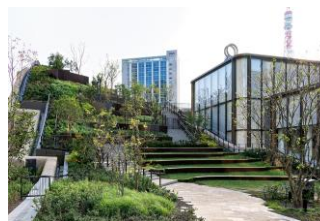
「スーパーソイル工法」 軽量緑化工法
