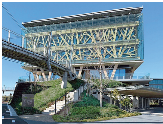
大成建設グループ次世代技術研究所/幸手
