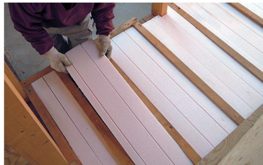
低密度でも高い断熱性を持つ自己消火性のビーズ法発泡ポリスチレン断熱材です。ポリマーの構造改良や、発泡剤などの配合を適正化することにより、揮発性有機溶剤(VOC)成分の含有量を従来グレードに比べ大幅に削減しています。
