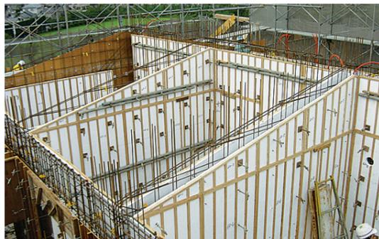
建設時の省力・省資源化、居住時の省エネを叶える型枠兼用断熱材です。断熱性に優れ、従来工法と比較して、コンクリート造集合住宅における空調使用時の電力使用量を、CO<sub>2</sub>換算で20%削減します。また、型枠設置・解体工程を省力化でき、工期短縮と建設廃棄物の削減にも貢献します。
