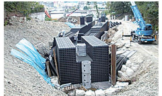
集中的な豪雨が発生した際などに道路の冠水被害や河川の氾濫を抑制するための雨水貯留浸透槽です。道路の地下を有効に活用できるほか、従来のコンクリート製貯水槽と比較して原料の生産から施工完了までのCO<sub>2</sub>排出量を57%削減できます。
