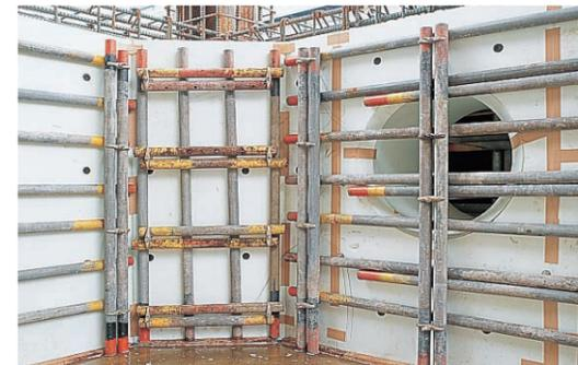
オフィスビルなどの、地下蓄熱層を形成するために用いる蓄熱槽用型枠兼用断熱材です。打ち込み型枠としての強度を兼ね備えた発泡ポリスチレン製の断熱材で、従来必要であった型枠の解体撤去および型枠合板の廃棄が不要となり、省資源化・省エネルギー化(工期短縮)に貢献します。
