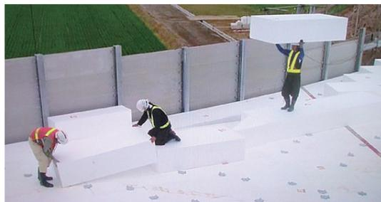
EDO-eps工法は、大型の発泡ポリスチレン(EPS)ブロックを積み重ねて盛土体を構築する軽量盛土工法です。軽量\*で人力での持ち運びができ、自立可能な「エスレンブロック」を盛土材とすることで、壁面に作用する側圧などを大幅に軽減し、擁壁に用いるコンクリートなどの資材削減が図れます。また、大型重機を必要としないため、施工条件の厳しい現場でも大掛かりな仮設をせずに短期間で施工することができ、施工時の省エネルギー化に貢献します。同じく軽量盛土材として使用される気泡混合軽量土と比較した場合、原料の生産から施工完了までのCO<sub>2</sub>排出量を48%削減できます。
